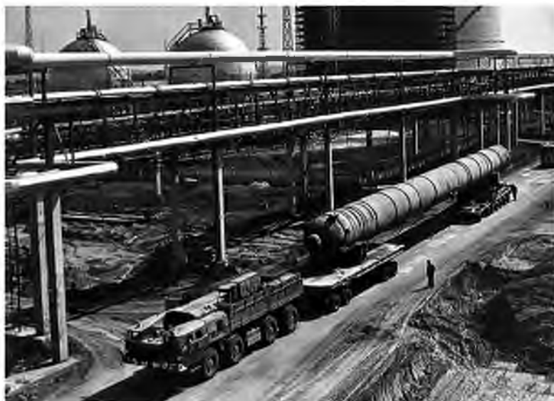
Транспортировка 100-тонного реактора фирмы «Кемико» на площадку строящегося агрегата аммиака №1
